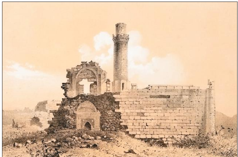
Рис.2. Разрушения на мечети с минаретом и на прилежащем культовом сооружении (на переднем плане) вблизи г.Шемахи на Кавказе после землетрясения 1859 г. Литография А.Мюнстера по рисунку О.Г.Хиппиуса, 1861 г.
